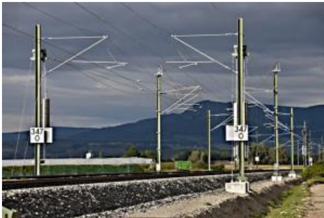
Die elektrifizierte Bahnstrecke zwischen Trasadingen und Wilchingen in diesen Tagen. Bild: Gerry Klaus
